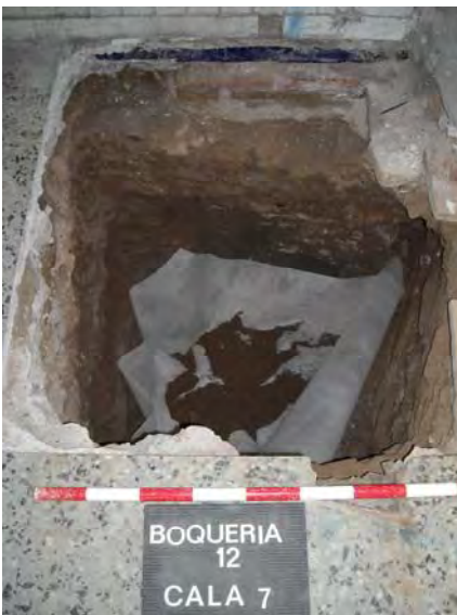
41. Cala 7. Instal.lació del geotèxtil
