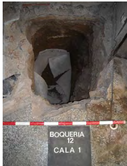
4. Cala 1. Instal·lació del geotèxtil
