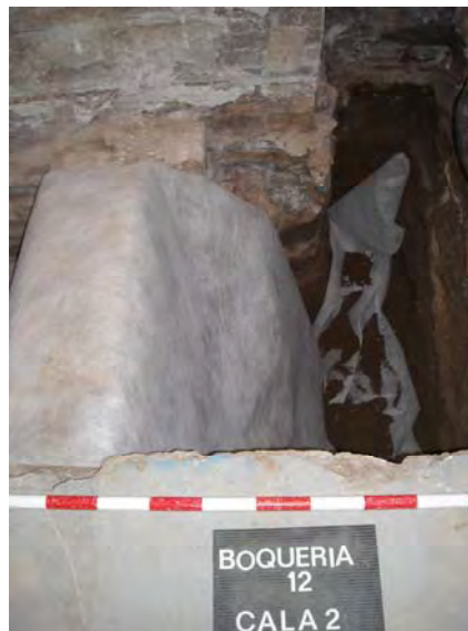
12. Cala 1. Instal.lació del geotèxtil
