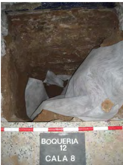
47. Cala 8. Intal.lació del geotèxtil
