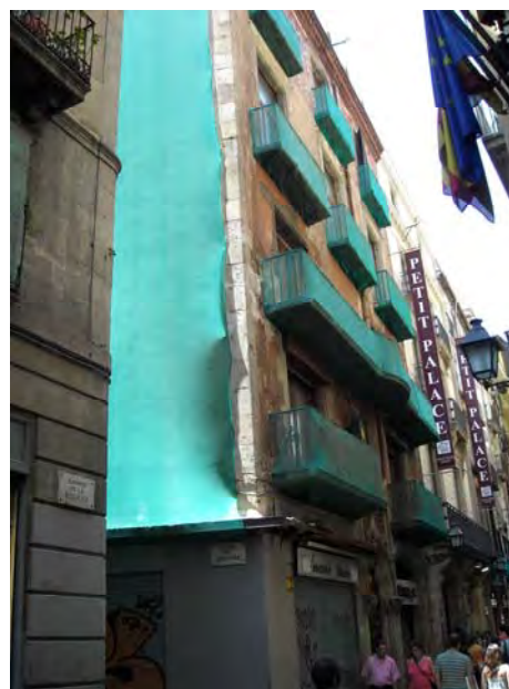
Fotografia de la finca presa des del carrer de la Boqueria
